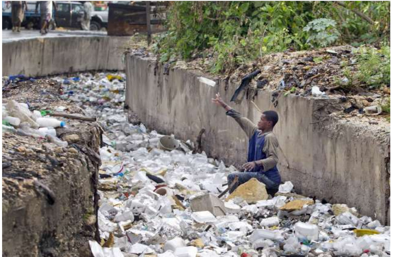
Ravine typique de Port-au-Prince, Haïti JPB architectes (Jean-Paul Boudreau architecte)
